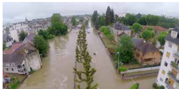
Montargis inondations juin 2016
