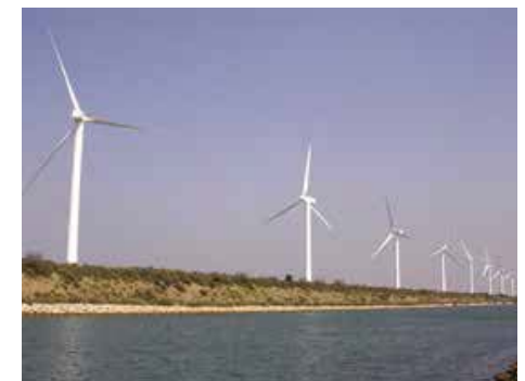
Delta du Rhône (Camargue, sud de la France). 21 éoliennes érigées en 2005 sur une digue. En 2006, 12 cadavres de chauves-souris ont été découverts dont un Miniopterus schreibersii . Permis de construire accordé à une époque où aucun diagnostic chiroptérologique n'était demandé pour une EIE, bien que ce site Ramsar fût un point chaud pour les oiseaux hivernants, les chauves-souris migratrices et les résidentes qui viennent y chasser. © E. Cosson
