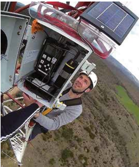
Système de détection automatique installé sur un mât de mesures en France. © EXEN
