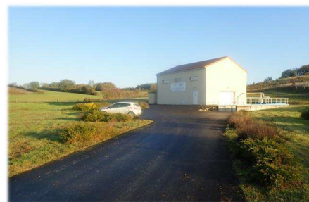
J4.2 – Réseaux routiers
