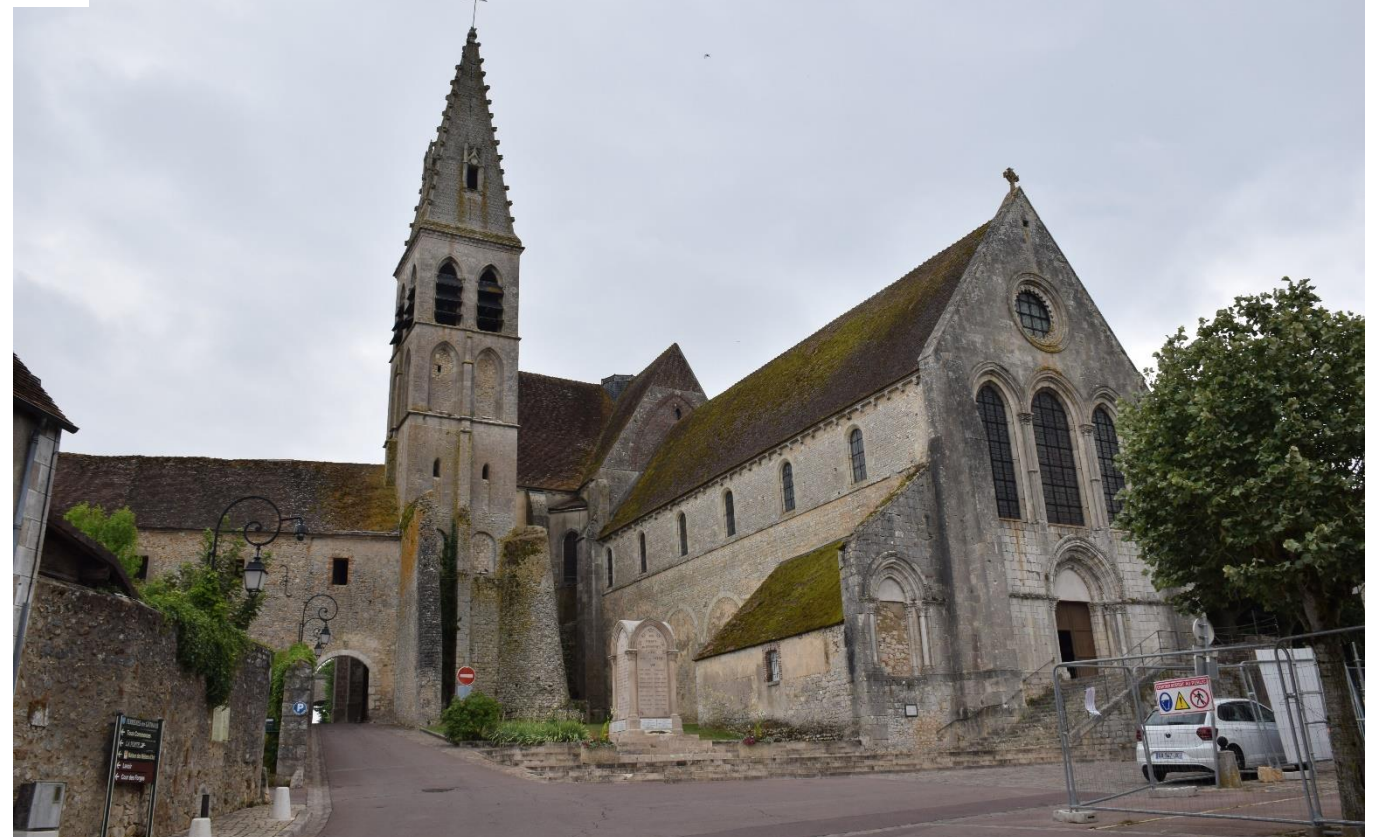
Figure 53 : Vue sur l'église de Ferrières-en-Gâtinais (© ATER Environnement, 2022)
