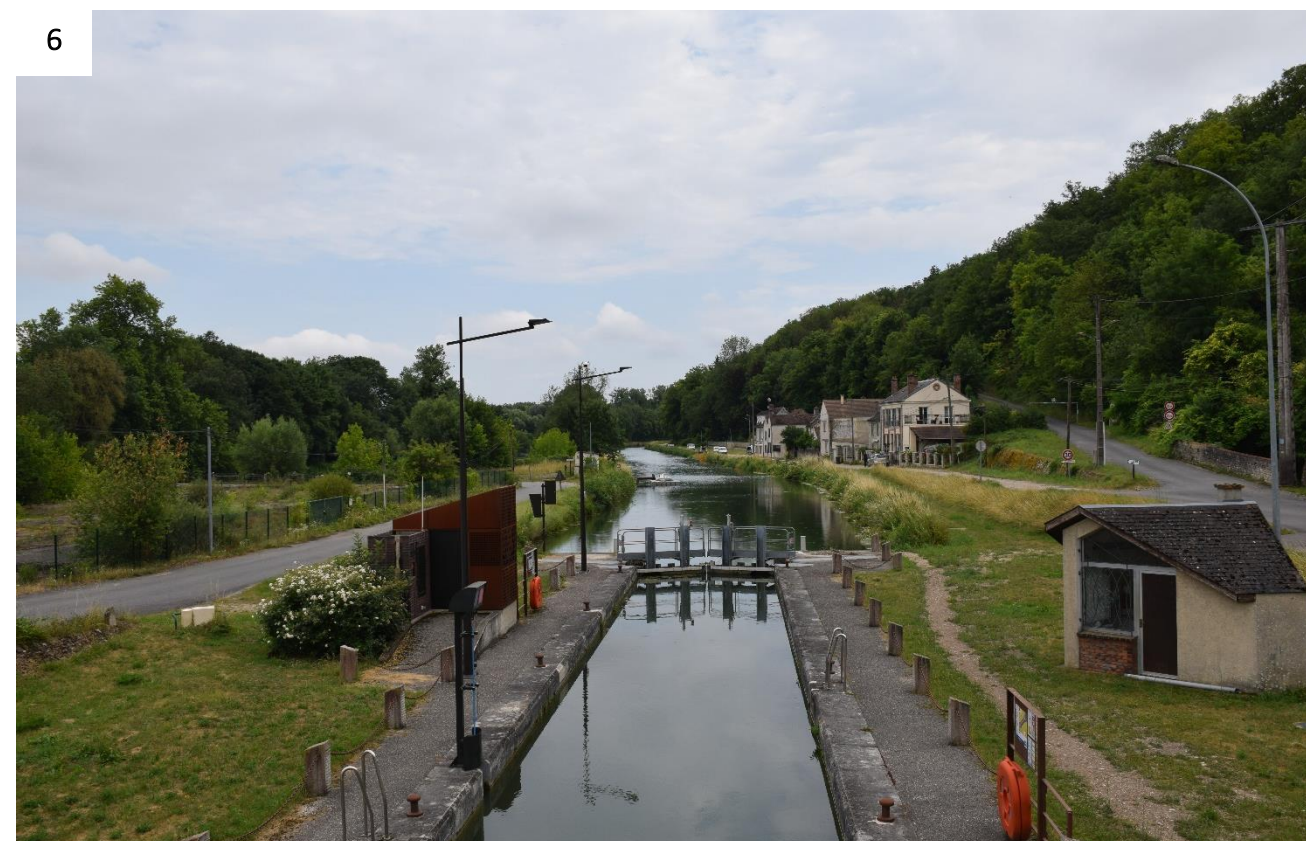
Figure 38 : Vue depuis l'écluse des Grands Moulins (© ATER Environnement, 2022)
