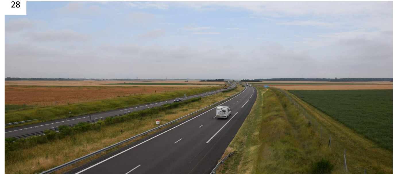
Figure 63 : Vue sur l'A77 depuis le pont de la D31 (© ATER Environnement, 2022)
