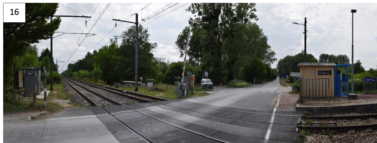
Figure 50 : Vue sur la partie nord du site depuis la gare de Dordives (© ATER Environnement, 2022)
