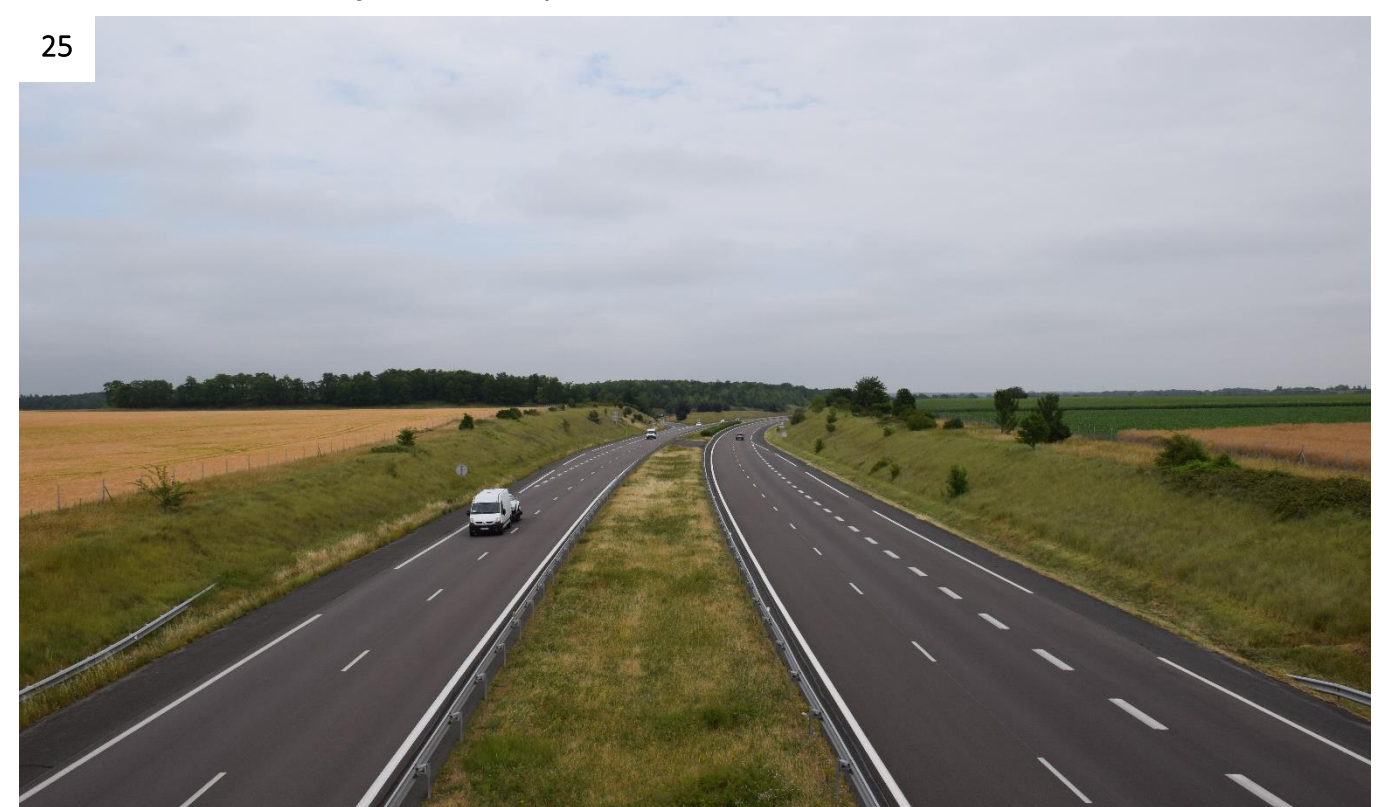
Figure 60 : Vue sur la D77 depuis la route communale proche de la Chapelle Bézard (© ATER Environnement, 2022)
