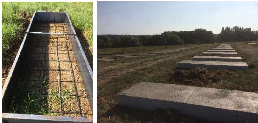
Figure 16 : Photographie de mise en place de longrine – source : ENGIE
