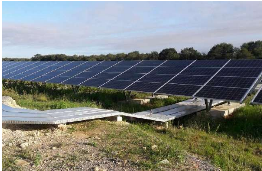
Figure 27 : Exemple de chemin de câbles
