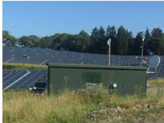
Figure 21 : Exemple de poste de livraison
