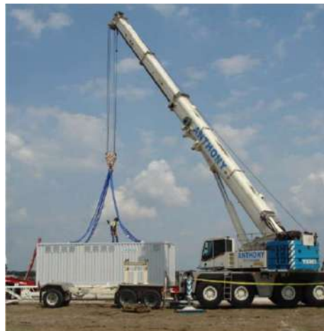
Figure 28 : Engin de levage utilisé pour la pose des postes onduleurs
