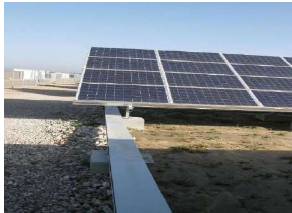
Figure 23 : Exemple d'un chemin de câbles
