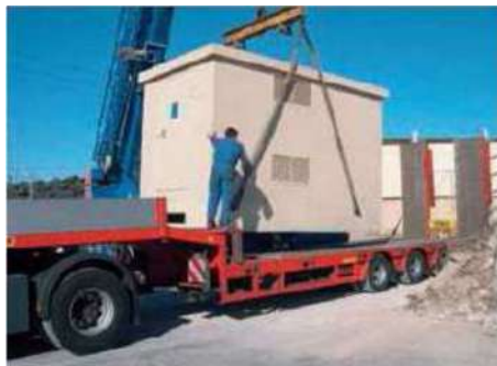
Figure 29 : Déchargement d'un poste électrique
