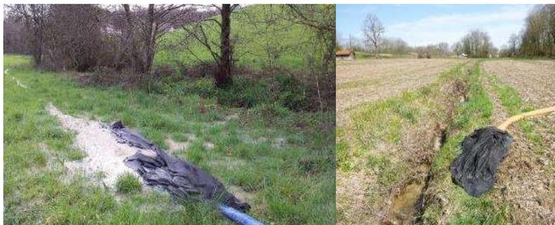
A gauche : rejet dans une « chaussette » en géotextile, orienté de façon parallèle au ruisseau et profitant d'une surface végétalisée, afin de favoriser la filtration naturelle. Au centre : rejet aménagé et orienté vers un fossé de drainage afin d'éviter le ruissellement sur la parcelle agricole.
