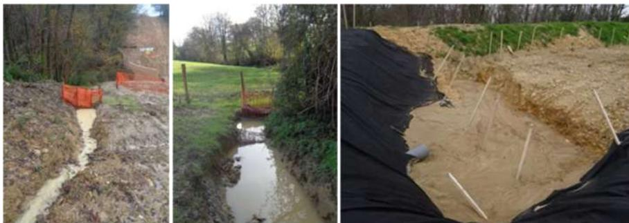
Photo de gauche et du centre : exemples de fossés de collecte acheminant sur des dispositifs filtrant (avant rejet en milieu naturel). Photo de droite : bassin de type piège à sédiments, à entretenir régulièrement après de fortes pluies (source : ARTELIA)
