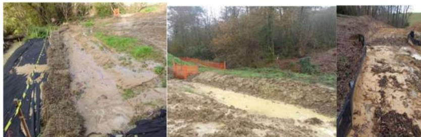
Exemples de pièges à sédiments (de gauche à droite : boudins de rétention, merlon et barrière géotextile), à privilégier le long des emprises de chantier, des cours d'eau et des zones humides (source : ARTELIA)
