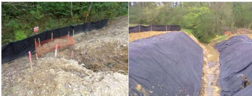
A gauche : exemple de protection multi-dispositif (fossé piège à sédiment + système tampon + barrière provisoire) entre une zone de déblais/remblais et une zone humide. A droite : couverture de berge mise à nus pour des travaux afin de protéger le cours d'eau des MES issues de l'érosion des talus (Source : ARTELIA)
