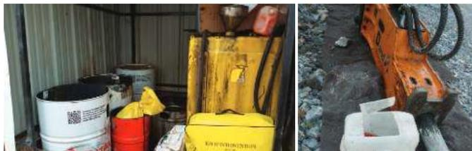
**Exemple d'une aire de stockage des matériaux polluants dans un conteneur étanche associé à un kit anti-pollution. Certains produits sont isolés du sol et disposés sur des bacs de rétention ou géotextile absorbant © AFB**
