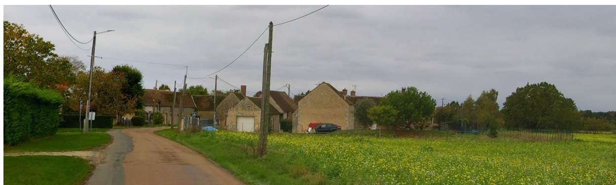
Figure 30 : Le hameau du Petit Ambreville, situé au sein du périmètre du SPR de Ferrières-en-Gâtinais
